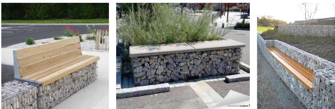
Figure 24 : Exemple de bancs en gabions
